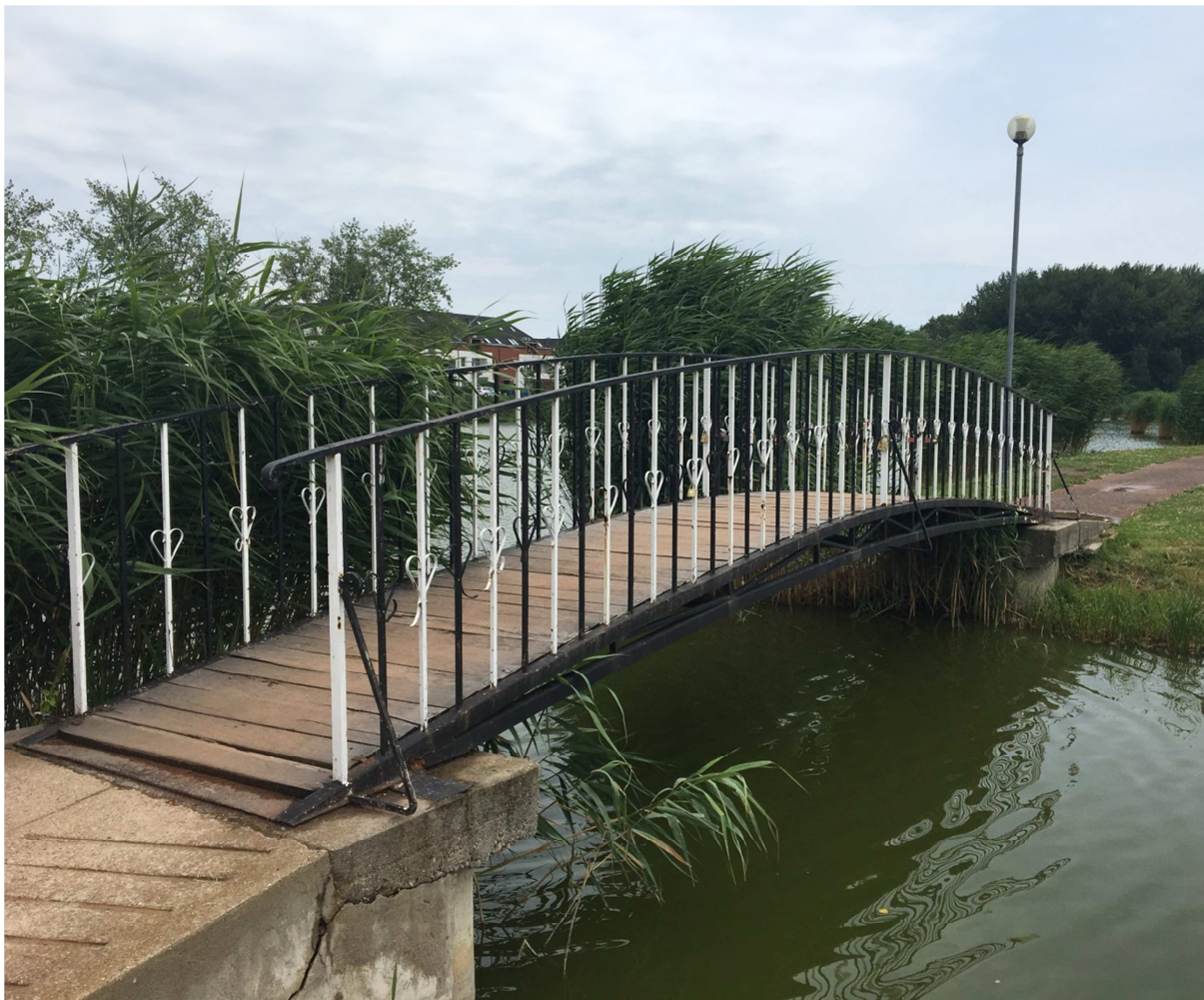
A hídszerkezet jelenlegi állapota
